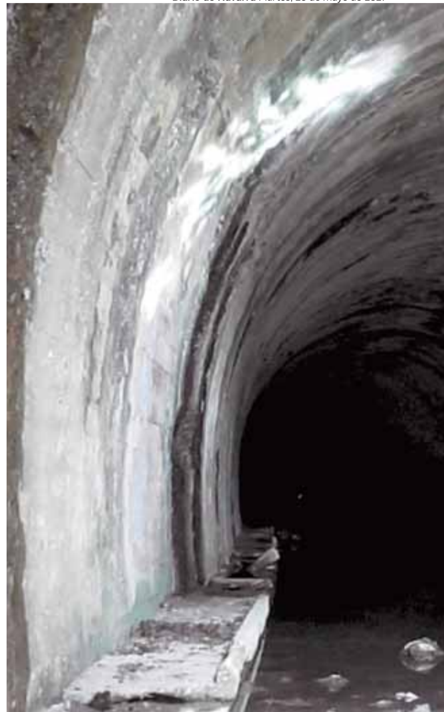
Momento en el que el elefante se adentra en el túnel de la Engaña, entre Burgos y Santander.
