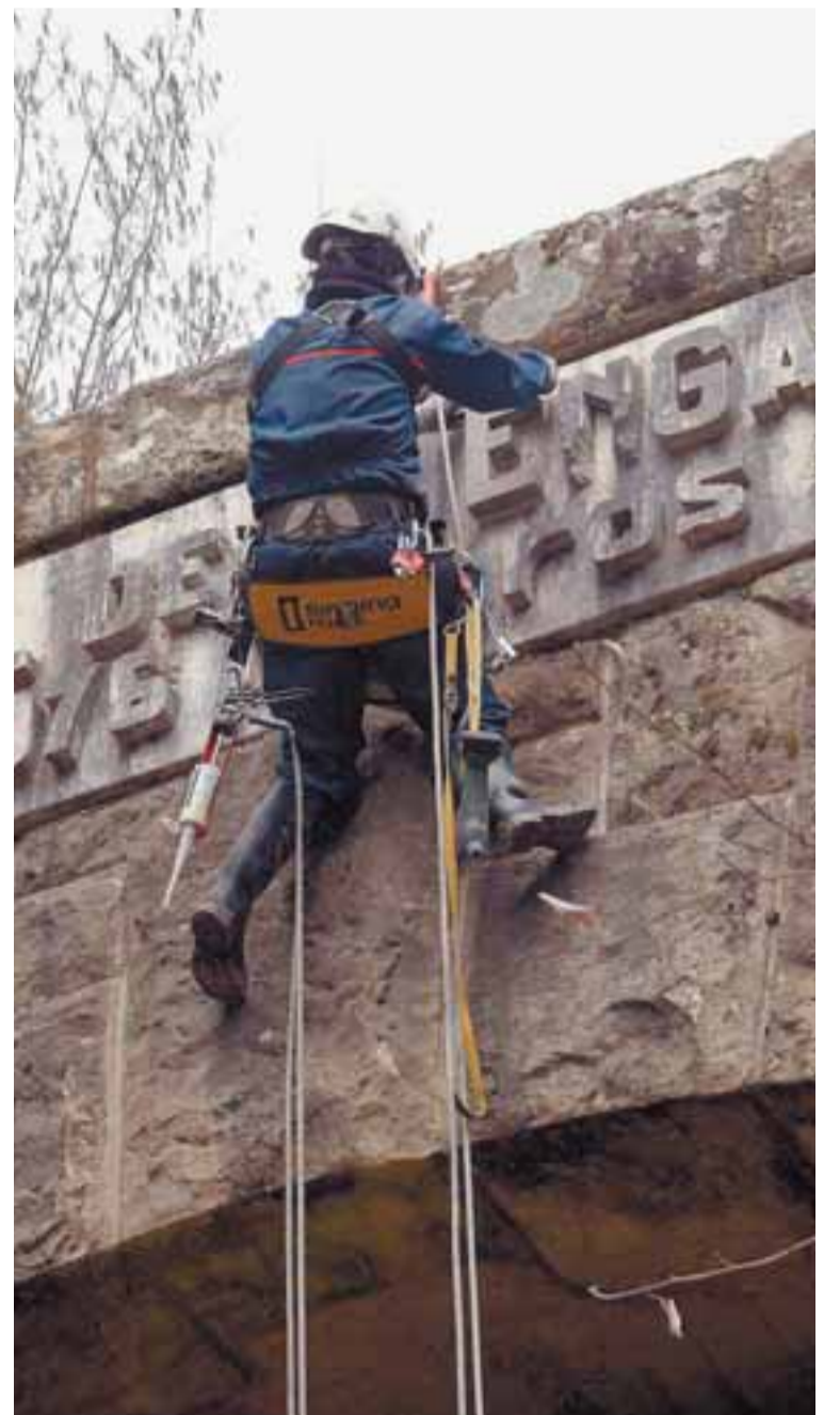
Restauración de la letra "e" que se había caído de la entrada. TXUSPOPOYO
